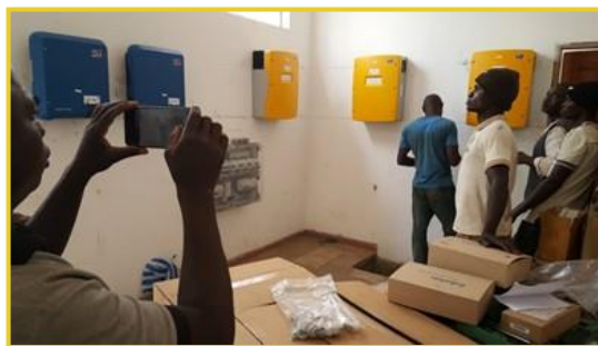
Imagen Izq. Módulos solares Canadian CS3U-P365. Imagen Der. Inversores STP SMA y SI SMA
